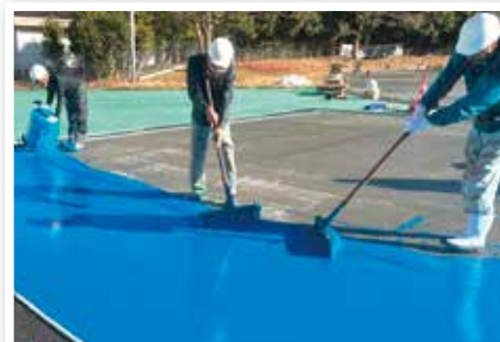
▲高い反発力とクッション性を生み出す液体状の樹脂素材を均一に塗り重ねる作業の様子
